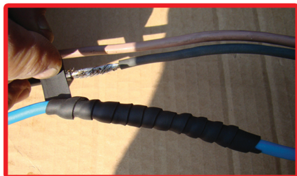
۸- شرایط روکش کردن سیم ها بوسیله نوار لستیک خام
