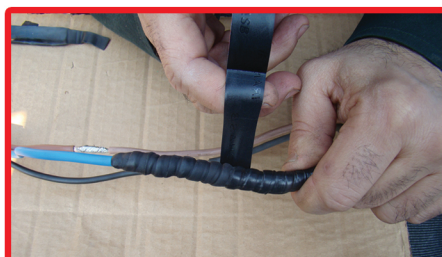
۹- نحوه روکش دوم بر روی لستیک خام بوسیله نوار چسب برق جنس خوب حداقل سه بار تکرار شود
